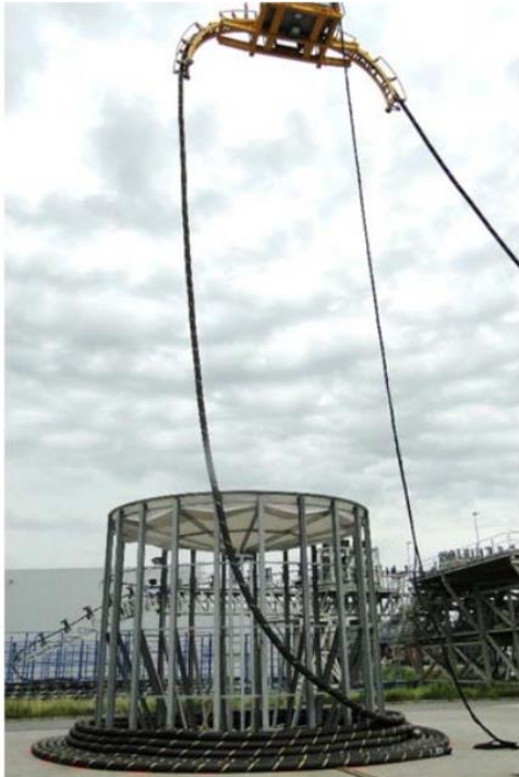
Hình 6: Thử nghiệm cuộn dây cáp điện ngầm XLPE 3x 800mm 2 19/33 (36) kV Vào bể tĩnh cố định
